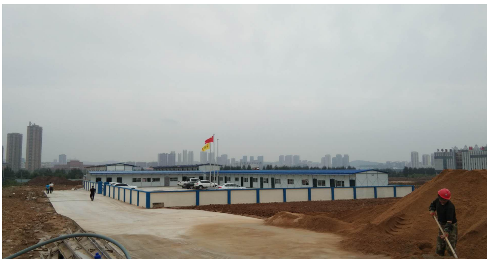
施工生产生活区
