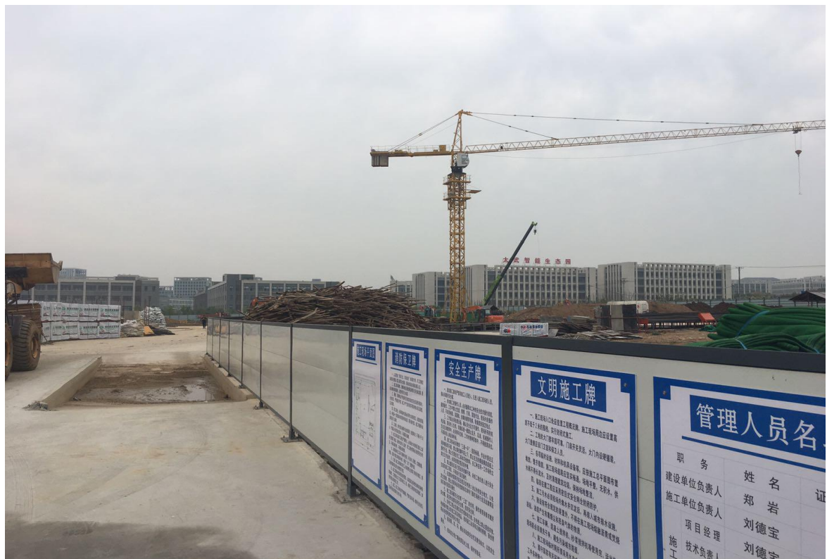
永临结合的道路
