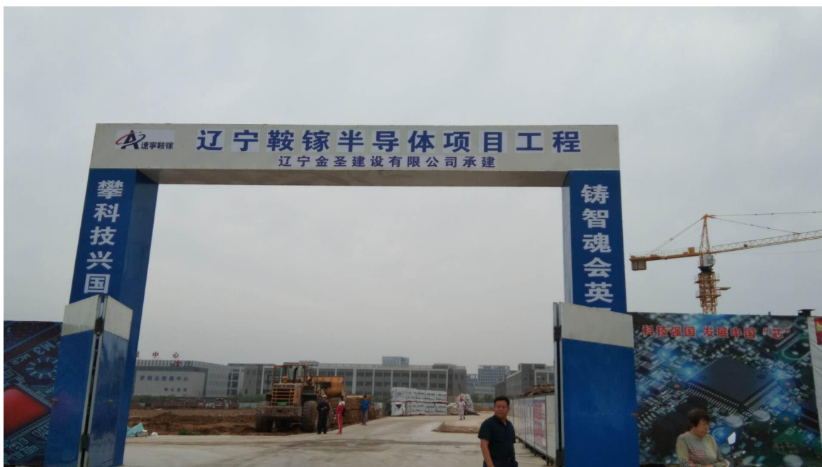
临时彩钢板拦挡
